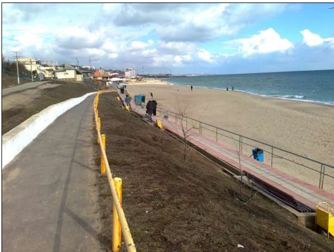
Рис. 2. Необмежований спорудами вільний штучний піщаний пляж , довжиною 400 м, що захищає територію міста Чорноморськ від дії абразії. Потребує регулярного підживлення. Можна бачити терасованість нижньої частини надводного кліфу (фото Ю. Д. Шуйського в грудні 2016 р.)
