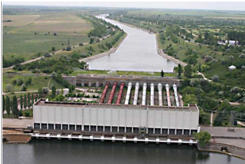
Рис. 1. Головна насосна станція Каховської зрошувальної системи
