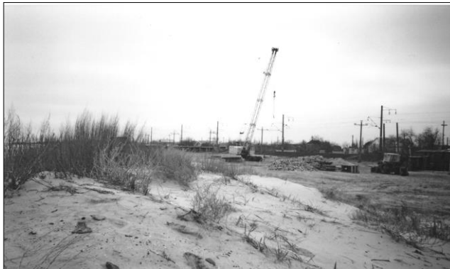
Рис. 2. Антропогенне порушення дуже крихкої еолової системи на піщаному пересипу Дністровського лиману.
